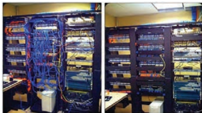
شکل ۴۱- مرتب کردن کابل‌ها
